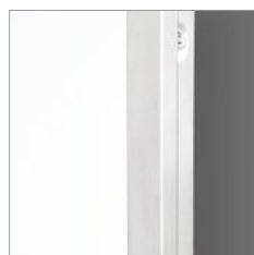
Przyłga zabezpieczona profilem ze stali nierdzewnej
